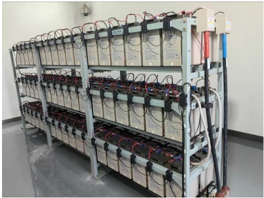
红星 110kV 变电站蓄电池室内的蓄电池
