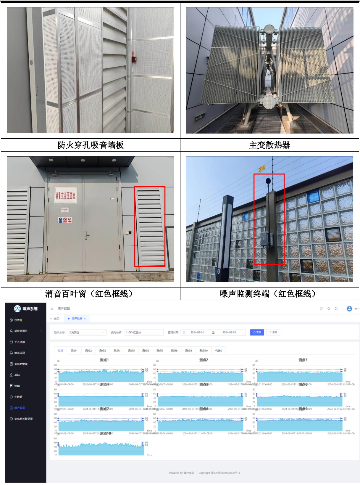
图 4-4 降噪设施及噪声实时监测系统
